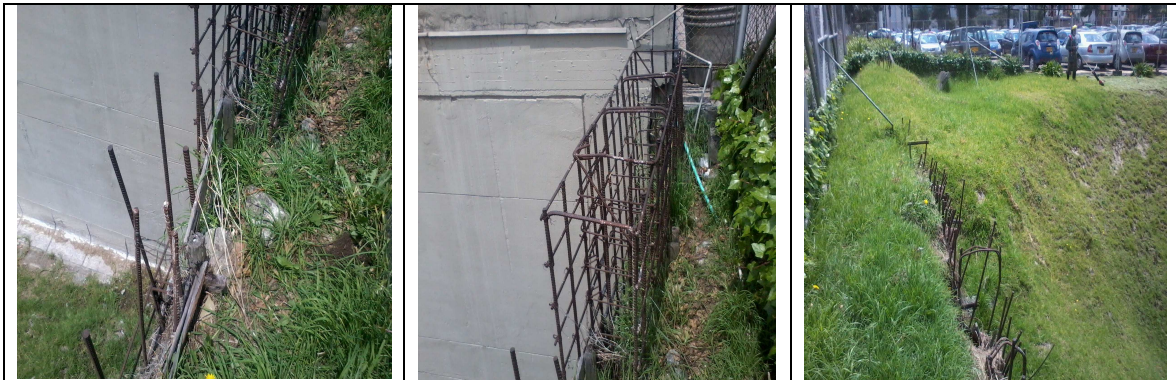
Fotos (1,2,3) Acero de Refuerzo de elemento estructural (Muro Pantalla) Predio: Maloka - Cra.68 D No.24A-51 Ciudad Salitre- Marzo 11 de 2013
